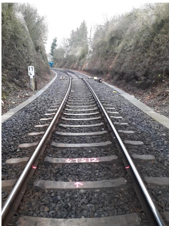
Bild 11: [km 17,380 - TS 12 Gleisabsenkung.jpg]
